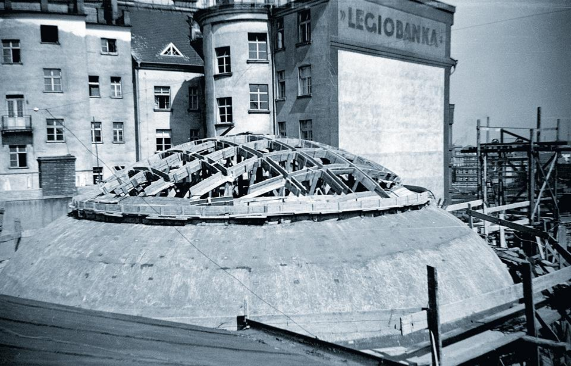
Stavba kostela – je připraveno bednění pro železobetonový rám proskleného vrchlíku.
