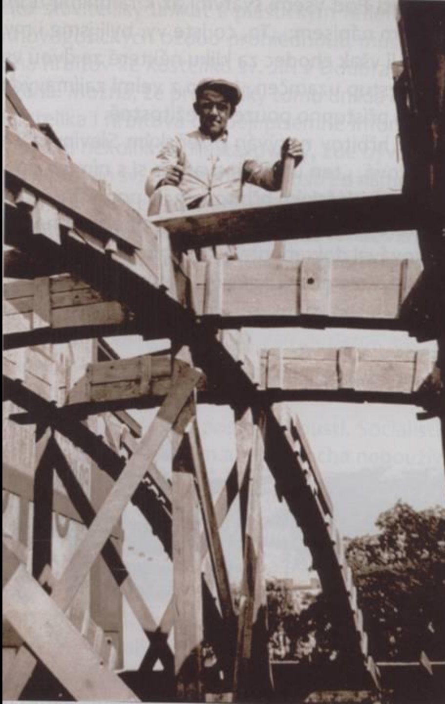
Stavba kostela – bednění pro kopuli
