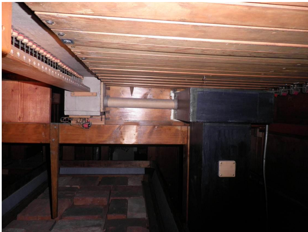
26. Abbildung: Die 1955 angebaute Zusatzlade für die Sesquialtera 2fach, abkonduktiert vom HW Windkanal
