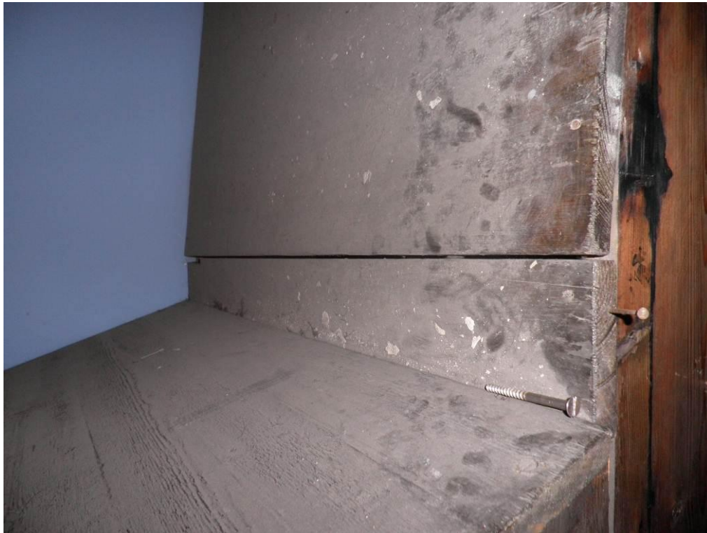
41. Abbildung: Geschwundenes Brett am Schwellgehäuse
