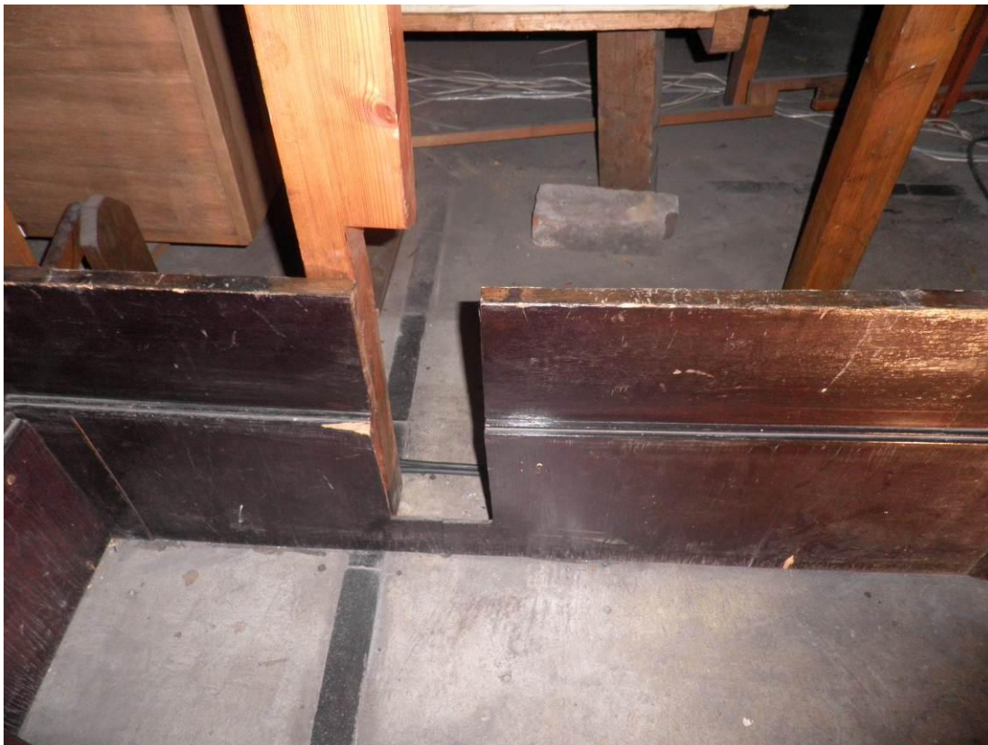
7. Abbildung: Ausschnitte für Tretbalken im Lagerwerk C# Seite
