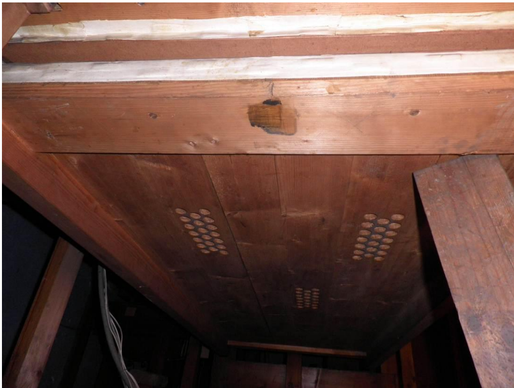
11. Abbildung: Ausgekeilte Schöpferbalg, Spuren der Tretbalken
