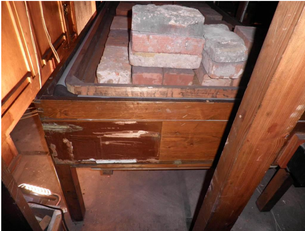
23. Abbildung: Zugemachte Windkanalschnitt am Magazinbalg
