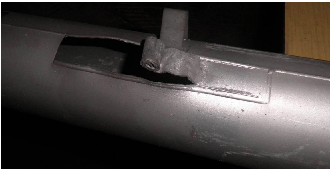
68. Abbildung: Beschädigte Stimmrolle einer Prospektpipe
