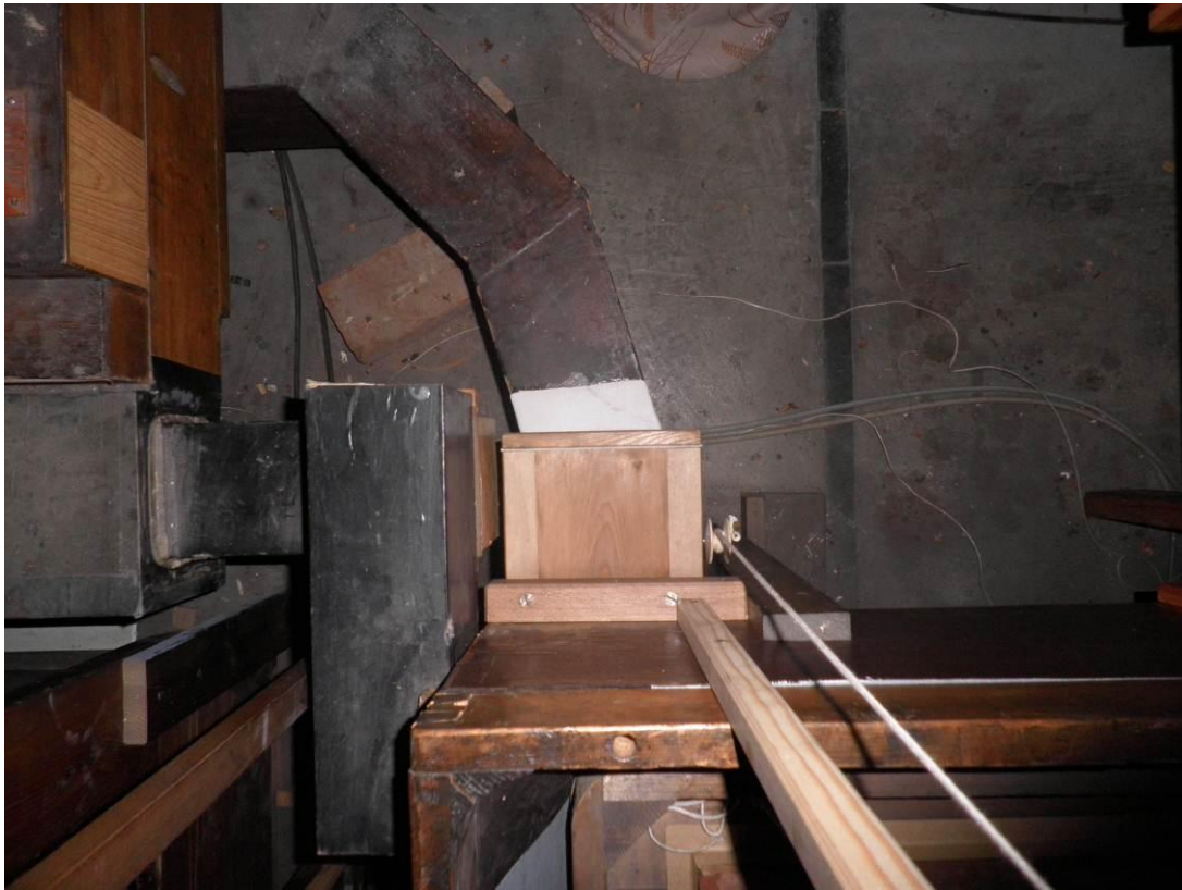
18. Abbildung: Das neu eingebaute Drosselventil
