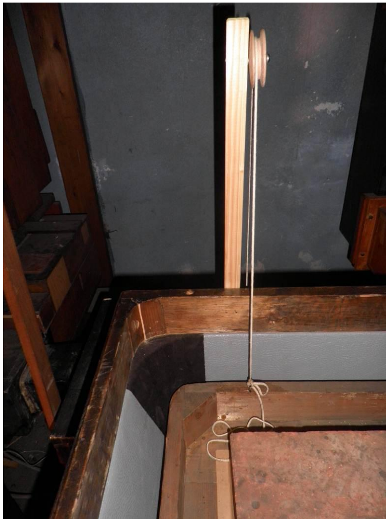
22. Abbildung: Regulierungsseil zur neu eingebauten Drosselventil
