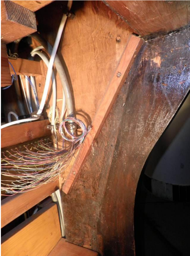
58. Abbildung: Spuren der ursprüngliche Position der Kniefüllung
