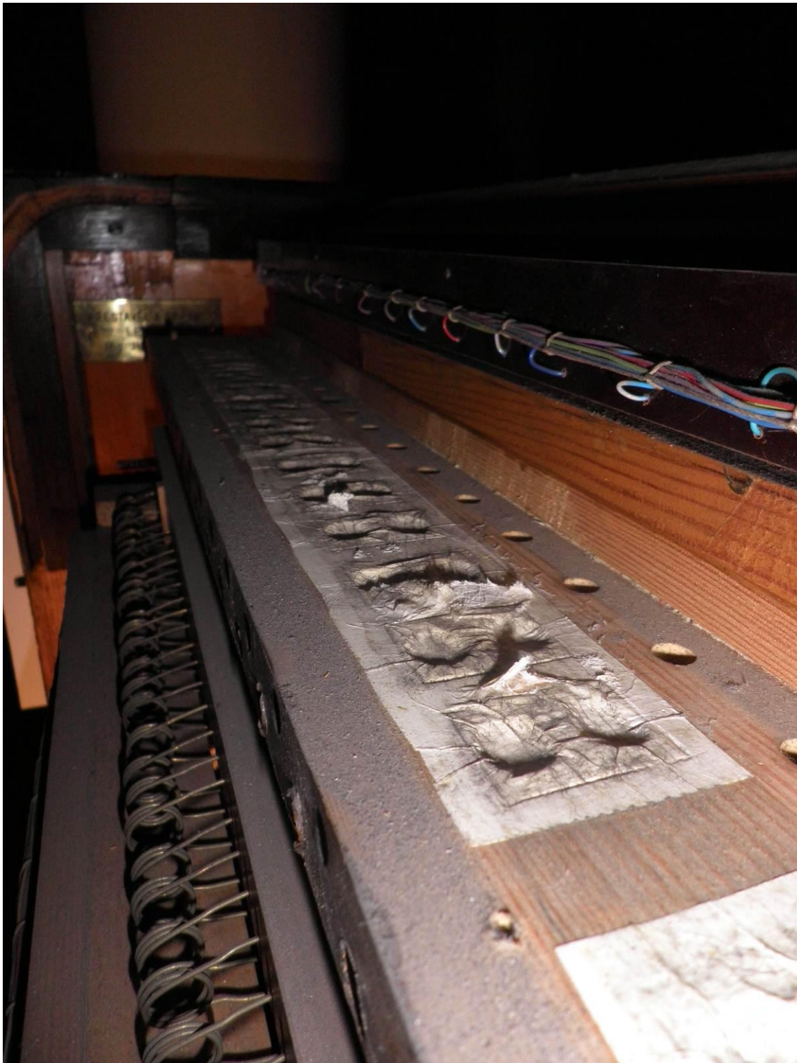
52. Abbildung: Kaputte Belederung der Membranenkoppel, vermutlich aus 1955
