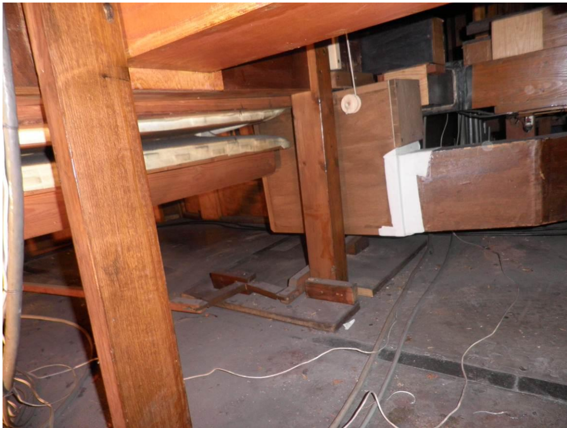
19. Abbildung: Das neu eingebaute Drosselventil
